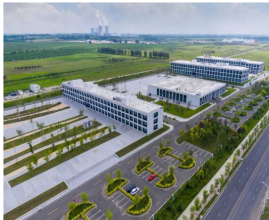
数据中心办公区实拍图
