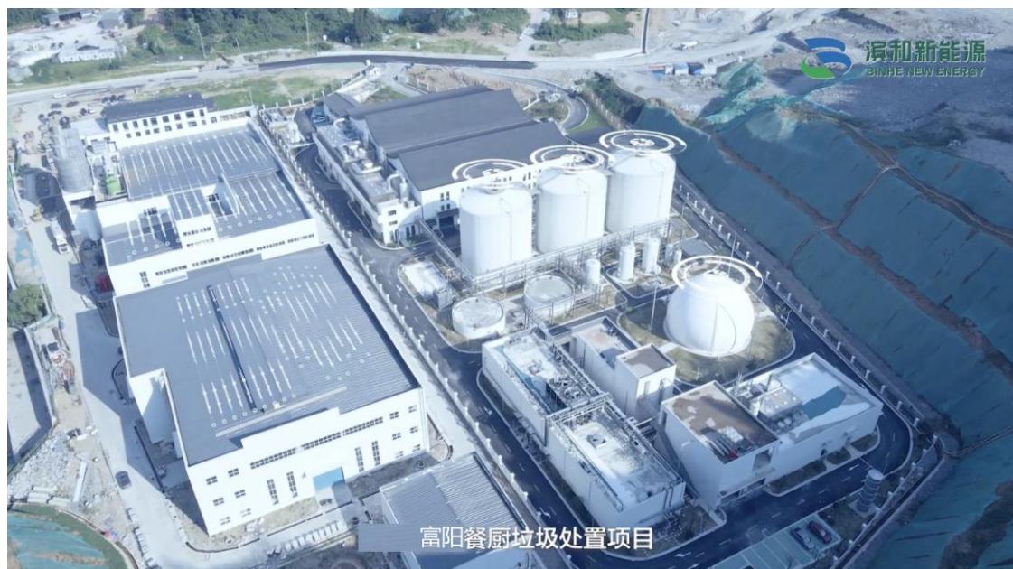
图 21 富阳区循环经济产业园餐厨垃圾处置项目
