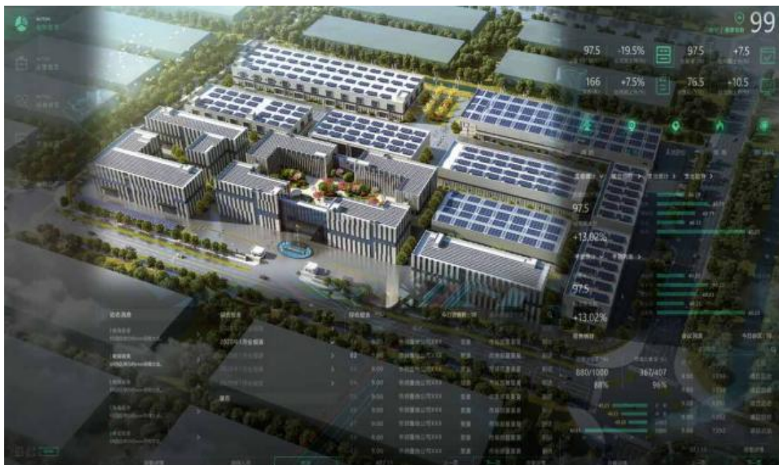
图 9 桃浦园区能源综合管理中心
