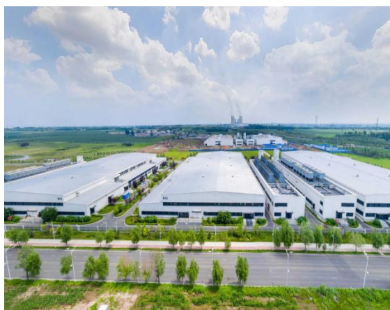
数据中心机房区实拍图
